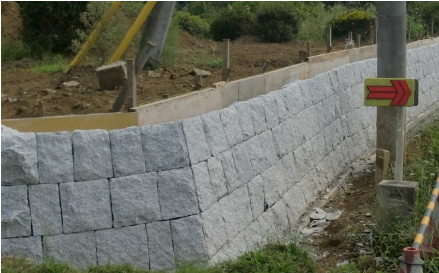
お客様からのご要望で、こちらの道路面は間知石積みに・・・ ※石表面を加工してあり表面は割り肌のようにして重厚感があります この石裏面にはコンクリートを充填して強度を保っております。 (写真はコンクリート打設前/裏面はコンクリート型枠設置)
