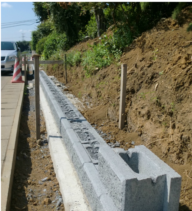
2 段目の施工～5 段目まで メーカーの施工要領書に基づいて順次 施工推移
