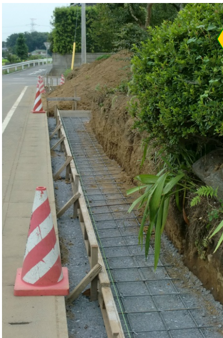
基礎ベースとなる 底盤の鉄筋
