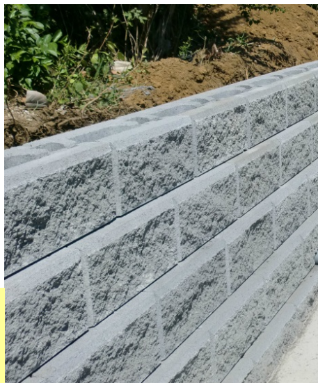
2 段目の施工～5 段目まで メーカーの施工要領書に基づいて順次 施工推移
