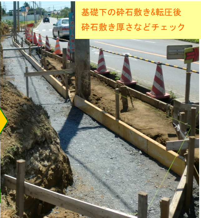
お客様からのご要望で、こちらの道路面は間知石積みに・・・ ※石表面を加工してあり表面は割り肌のようにして重厚感があります この石裏面にはコンクリートを充填して強度を保っております。 (写真はコンクリート打設前/裏面はコンクリート型枠設置)
