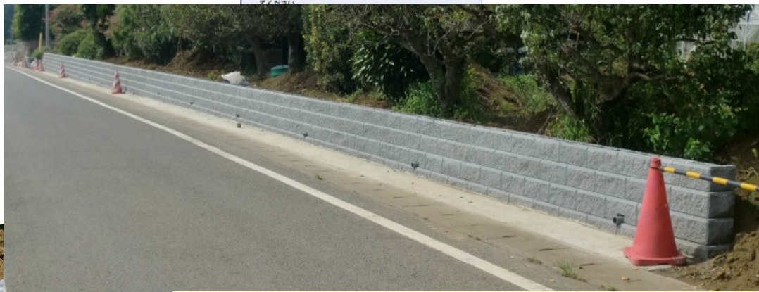
5 段目まで施工完了 (水抜きパイプを所定本数設置) 擁壁ブロック裏側に裏込め砕石を所定厚さ(30cm) 敷き込んだ後に 土の埋め戻し
